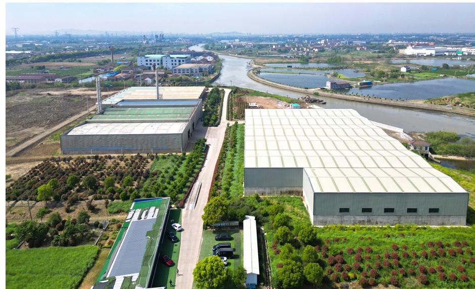
常州市天绿生态有机肥有限公司位于洛阳镇，是江苏省环太湖城乡有机废弃物处理利用示范点，可实现农业、绿化、藻泥及其他各种有机废弃物的资源化利用。为扩大生产需求，公司在现有洛阳中心的基础上扩建、新建三个中心（洛阳、前黄、嘉泽）。目前，洛阳中心改扩建工程已完成（如图），投用后可实现年处理有机废弃物8万吨、年产有机肥5万吨。
