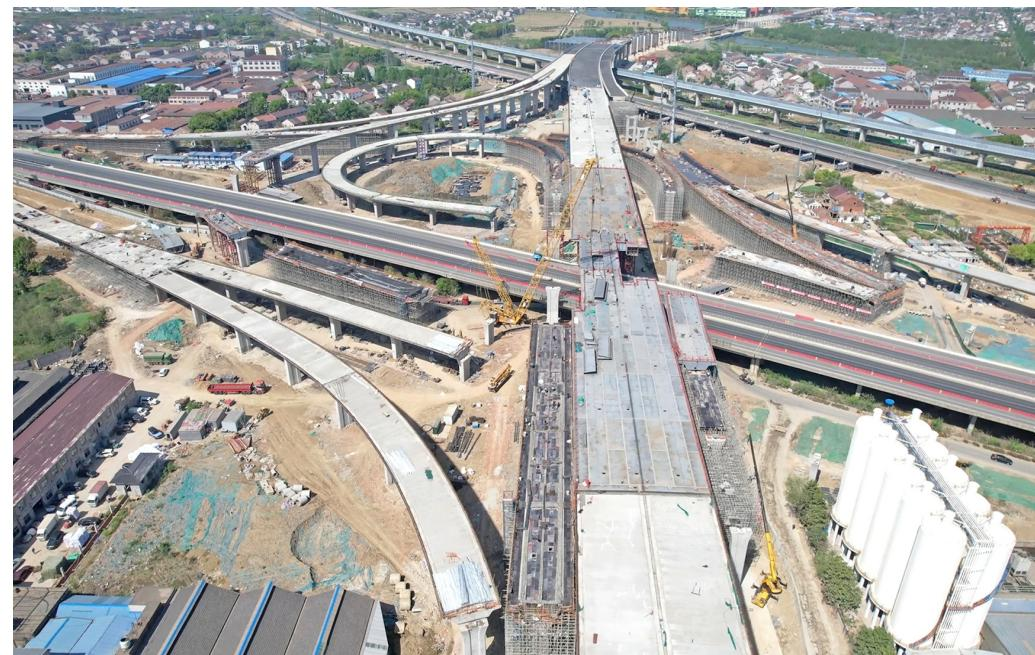
本报讯 (记者 万峰鸣)近日,G312快速路工程项目上跨S232钢箱梁顺利合龙,标志着项目桥梁上部结构施工取得重要进展,为后续G312跨S232互通全线贯通奠定了坚实基础。
