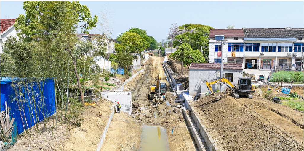
雪堰镇洋泽浜河道综合整治及水土保持工程项目总投资 400 余万元，结合水系沟通、水环境整治、水土流失治理，对 2.1 公里主河道和 0.43 公里支浜河道进行综合整治。目前，项目已完成总进度的 80%，预计本月底完工。 陆新 钱垒 摄
