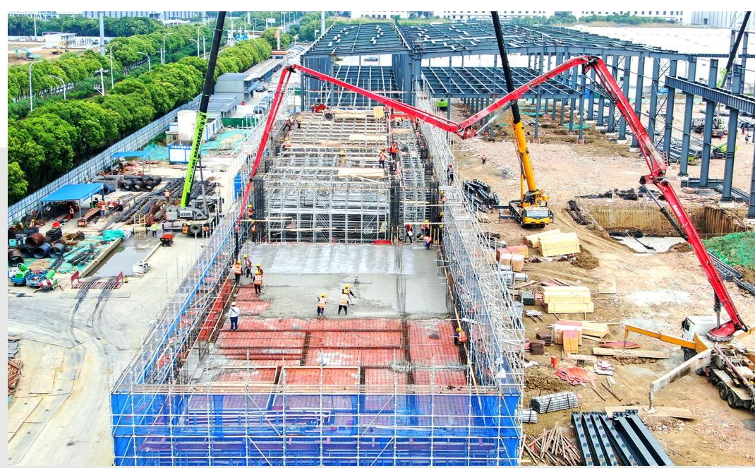
区重点项目常州燕龙汽车车身轻量化零部件生产项目位于武进国家高新区, 目前正浇筑基础短柱, 预计8月下旬钢架结构厂房竣工。该项目引进专用燃气加热炉、激光切割机等进口设备54台(套), 配套自动焊接设备、空压机等国产设备479台(套), 建成后可形成年产热成形车身轻量化零部件600万件的生产规模。陆新 徐晶伟 摄
