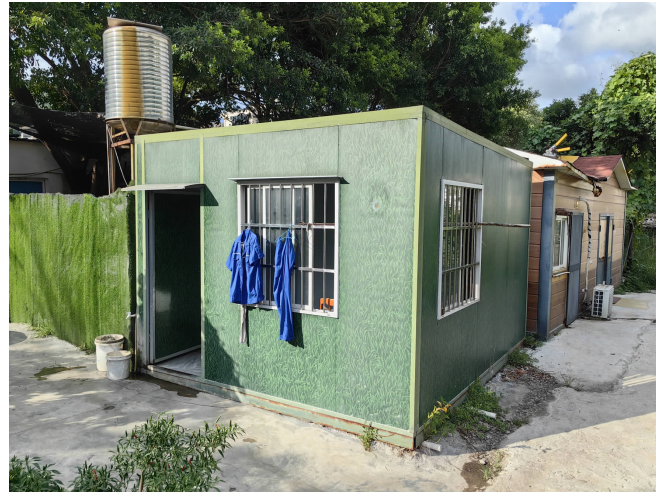
板房周边未见液化气罐,属于临时“借用”
