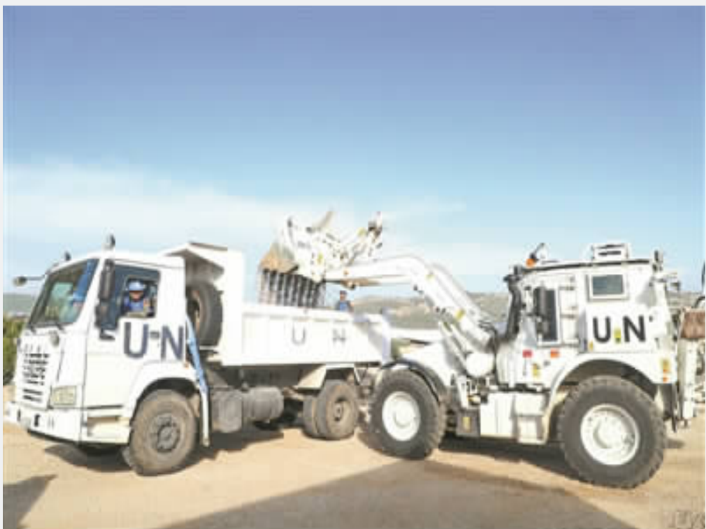
根据安全形势需要和联黎部队司令部安排,中国第22批赴黎巴嫩维和多功能工兵分队日前连续出动兵力装备,为维和友军营区转运防卫工程材料。
