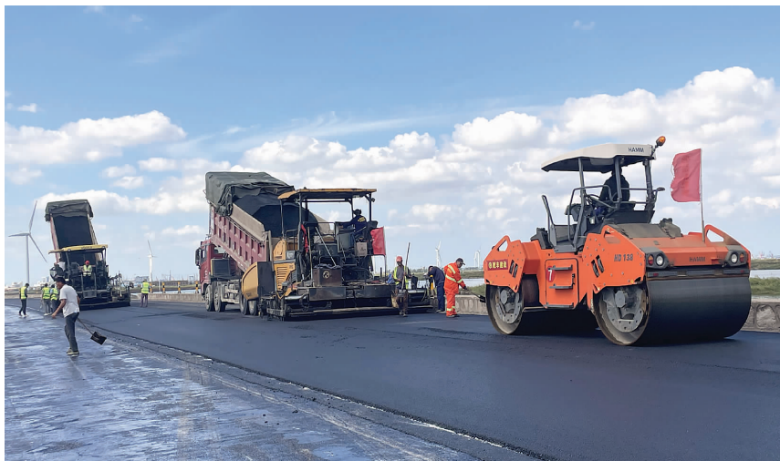
9月24日,在海堤海防战备公路拓宽改造工程施工工地上,机器轰鸣,工人们奋战一线,全力推进工程建设进度,确保在国庆期间具备通行条件。记者 汪正清 摄
