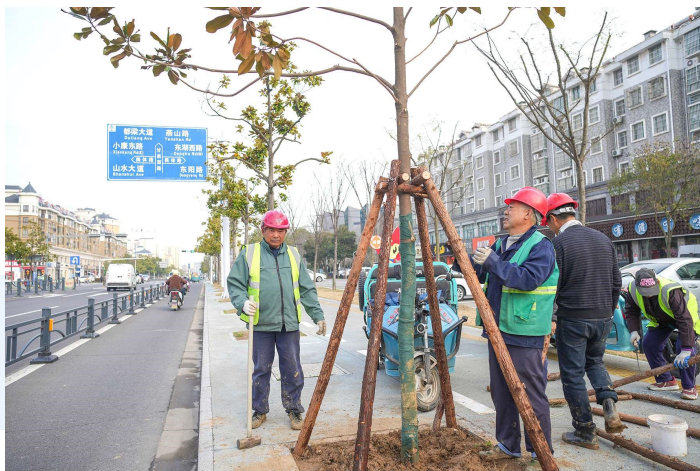
近日,县园林管理处为甘肃西路上新移植的景观树使用支撑架进行固定,确保其具有抗风能力,防止倒伏,利于树木顺利扎根生长。 融媒体记者 张瑞清摄
