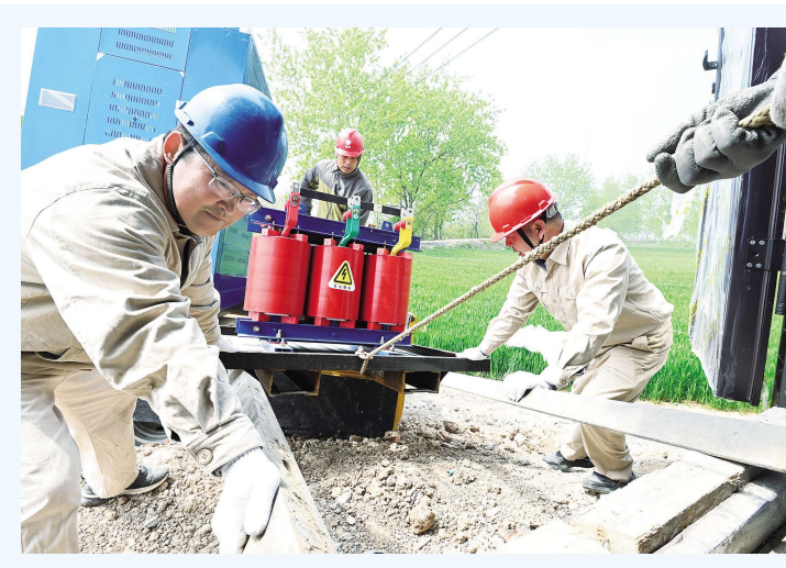
近年来,我县累计建设改造高标准农田47.69万亩,其中2024年建设改造2.869万亩。图为近日,鲍集镇灌庄村大嘴水泵房前,国网集供变电所员工与泵房建设工人将160千伏的干式变压器往泵房内牵引。
