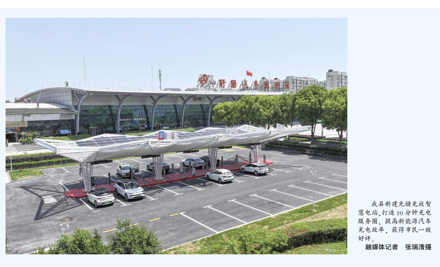
我县新建光储充放智慧电站，打造10分钟充电服务圈，提高新能源汽车充电效率，获得市民一致好评。
