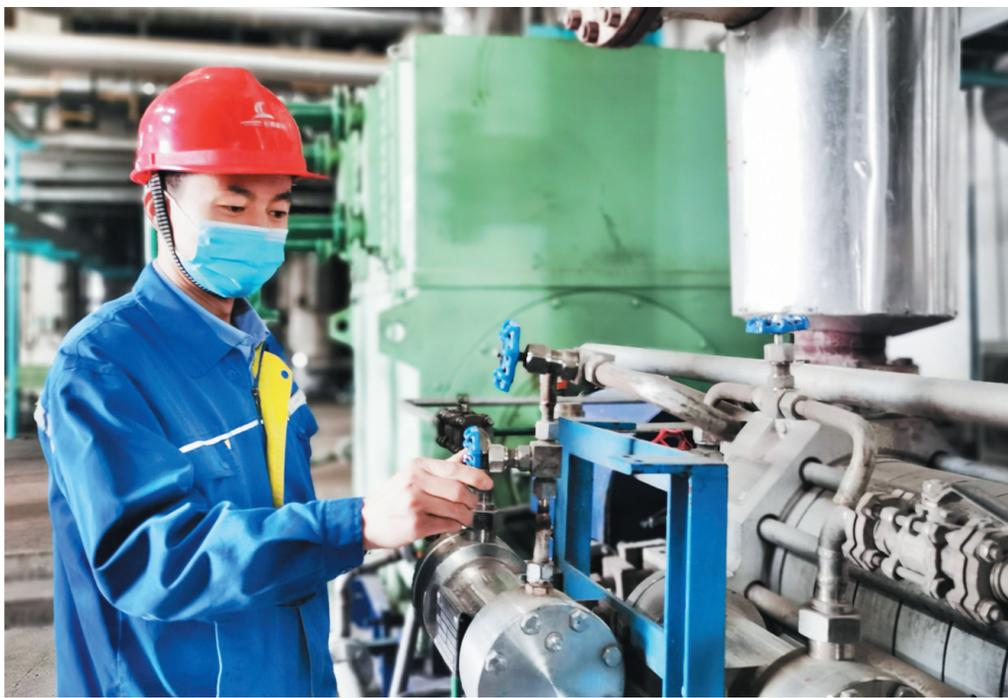
自开展安全生产大检查以来,长青能化公司将安全管理与班组建设紧密结合,不断强化“6S”班组、无“三违”班组创建,狠抓班前排查、班中控制、班后分析,有力提升现场安全管理水平。图为该公司巡检人员正在进行密封水压力表校验。
