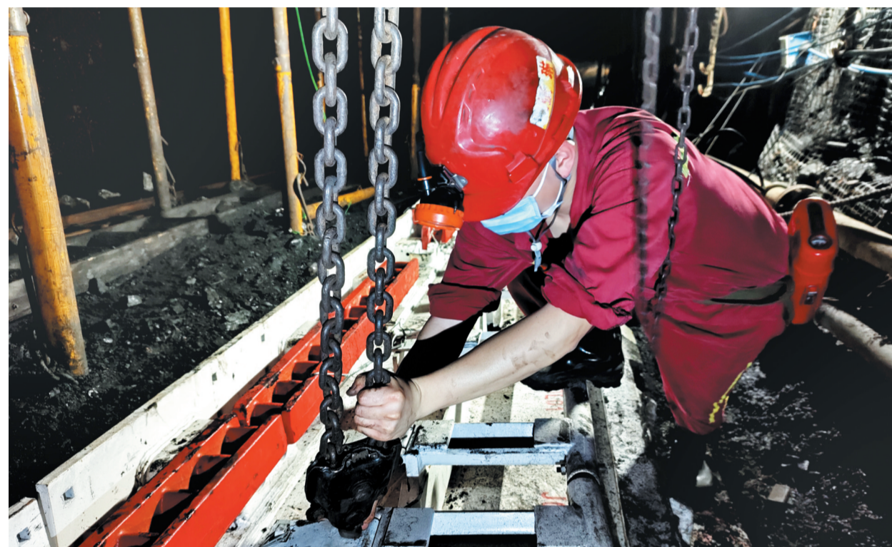
进入二季度以来,张双楼矿干部职工紧盯时间任务“双过半”目标,以时不我待的紧迫感和责任感,全力以赴抓安全、促生产、提效益,为业兴家旺新徐矿现代化建设作出更大贡献。图为工作人员正在现场组装刮板输送机。
