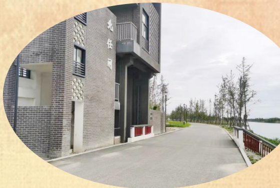
迎阳社区排涝站
