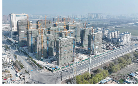
宝馨花园安置房项目建设现场
