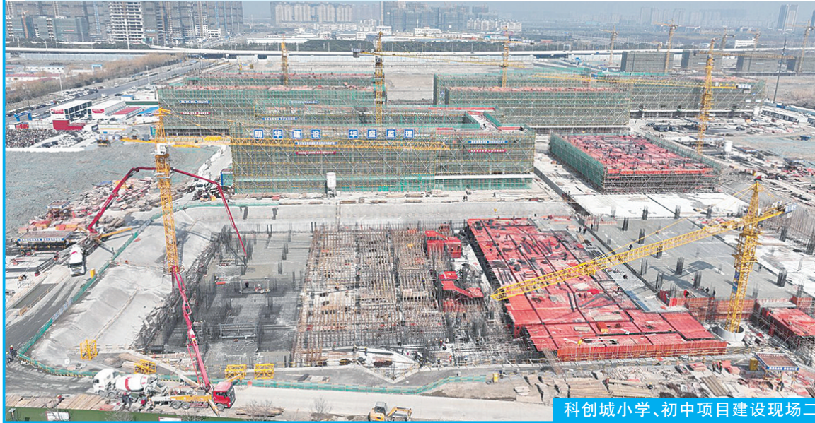
科创城小学、初中项目建设现场二
