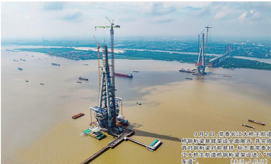
9月2日,常泰长江大桥主航道桥钢桁梁悬臂架设全面展开,并完成首对钢桁梁对称悬拼,标志着常泰长江大桥主航道桥钢桁梁架设进入“快车道”。(来源:人民网)
