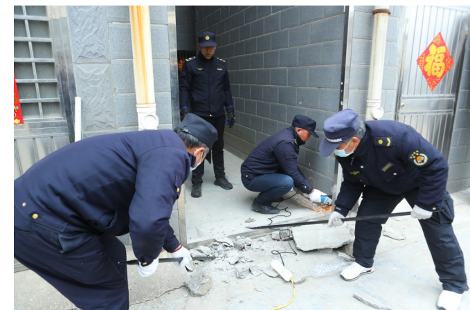
连日来,大纵湖镇组织安监、公安、消防、城管等部门工作人员深入辖区住宅小区开展消防通道安全大排查活动,对阻碍通道障碍的立即拆除清理,确保消防安全。
