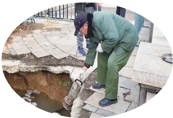
工作人员进行抽水作业。
