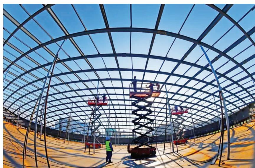
8月22日，仪征化纤公司年产300万吨PTA项目配套的首个30000立方PX储罐子午线制作完成，即将进入壁板制作。目前，项目建设进展顺利，主装置及外围公用工程陆续交安，PX罐区、厌氧反应区设备现场制作安装。
