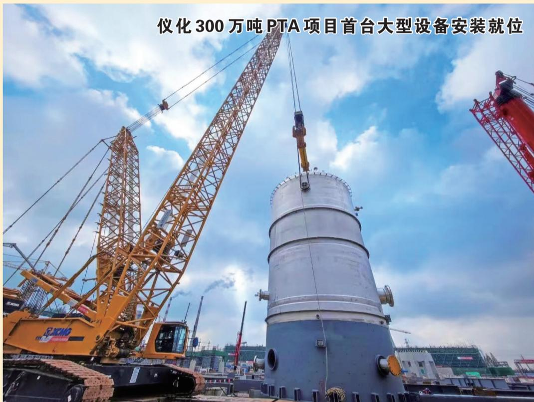
近日,中国石化仪征化纤公司年产300万吨PTA项目首台80吨重的压力精馏塔回流罐安装就位,预示着该项目建设全面进入大型设备安装阶段,向按期建成、投产的目标又迈出了坚实一步。
